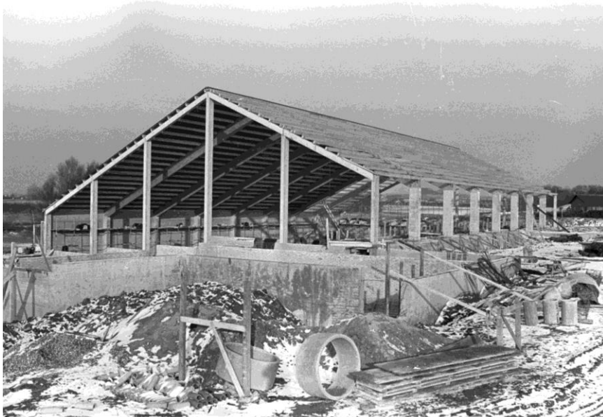
Spærene er rejst til Munkebo Hallen, der langt hen ad vejen blev opført af frivillige værftsarbejdere samt frivillige fra forenings-, forretnings- håndværkerlivet.
