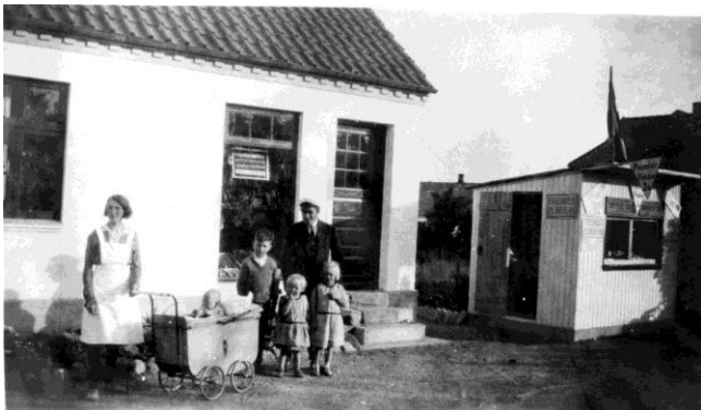
Aksel Andersen med hustruen Birgitte og børnene Svend Aage (i barnevognen), Bernhard, Grethe og Inger. Bygningen til højre fungerede som ishus. Foto fra 1933.
