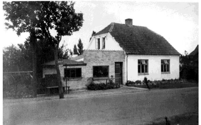
Fjordvej 103 i 1948. Bemærk tilbygningen til venstre. Desuden er indgangsdøren til højre i den oprindelige bygning sløjftet.
