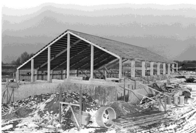
Spærene er rejst på Munkebohallen
